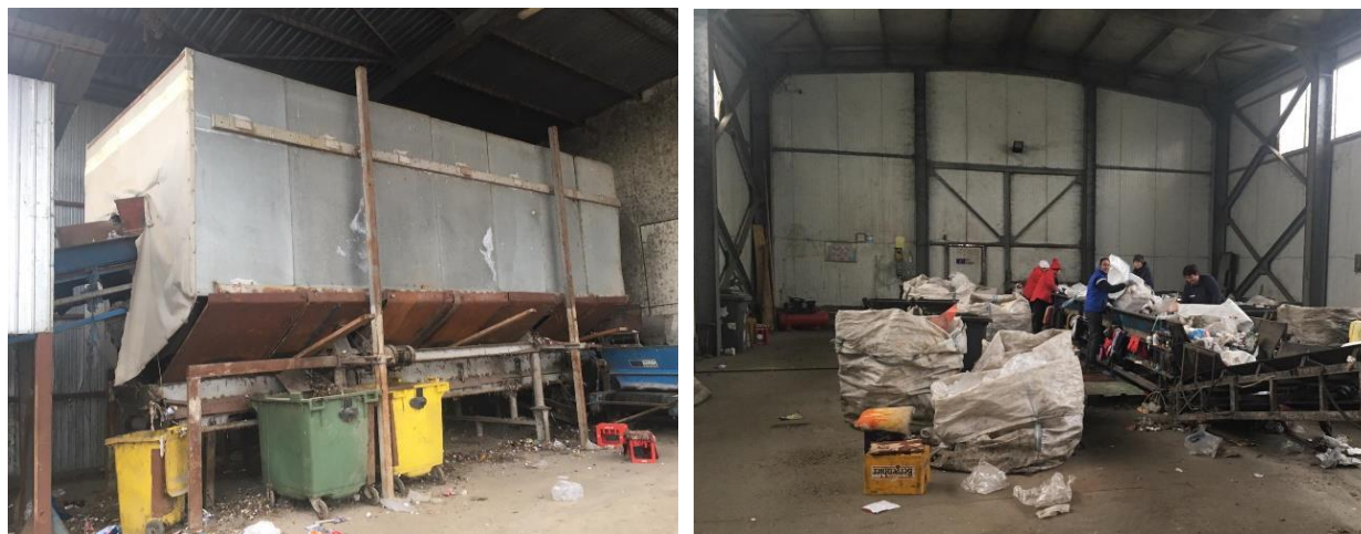
Fig 44. Stația de sortare S.C. ADI ECOO 2009 Țândărei
